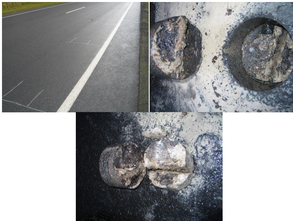
Rysunek 2.10 Sieć zaznaczonych punktów odniesienia użyta przy namierzaniu niewidocznego pęknięcia z precyzją kilkucentymetrową oraz widok otworu i fragmentów rdzenia W2_A1_S zaraz po odwierceniu.
